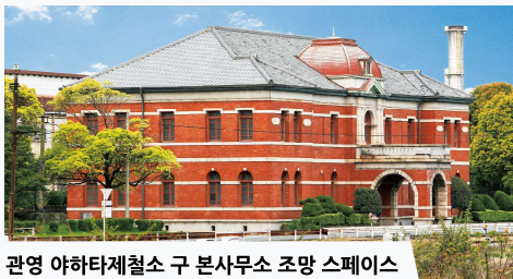
관영 야하타제철소 구 본사무소 조망 스페이스
